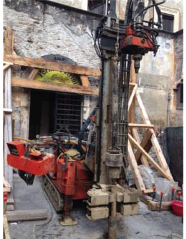
Phase d'exécution de forage
