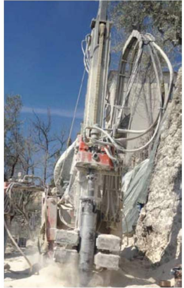
Construction de cloison étanche de micropieux
