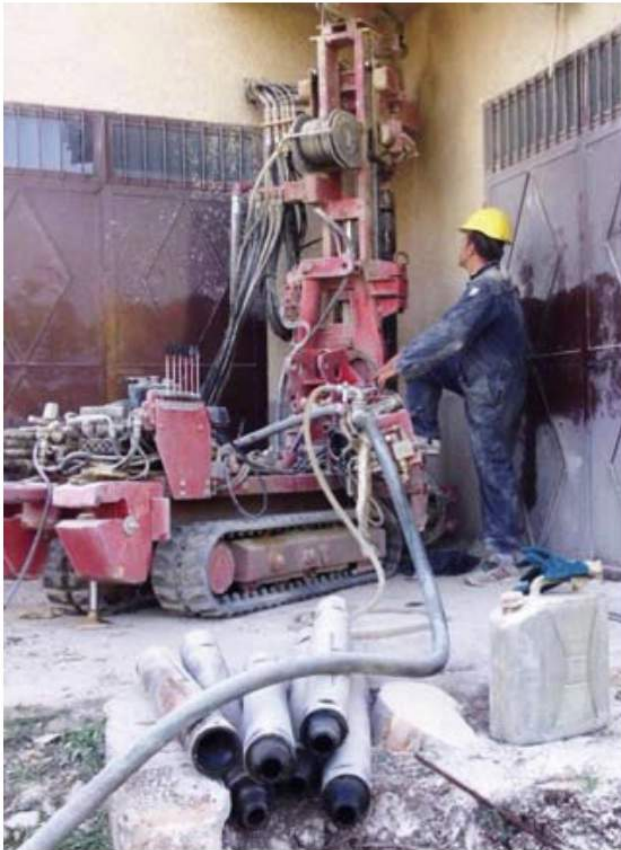
Forage avec marteau fond de trou
