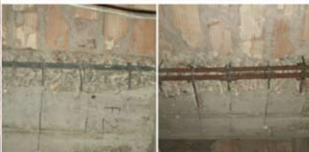
Extraction des barres d'armature
