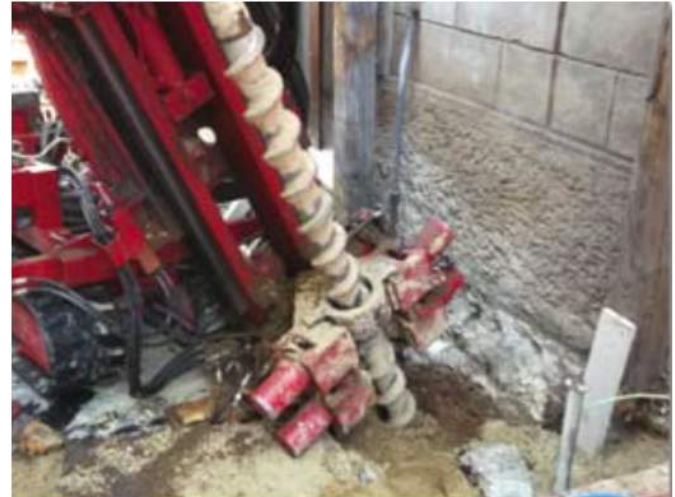
Forage avec enclères hélicoïdal
