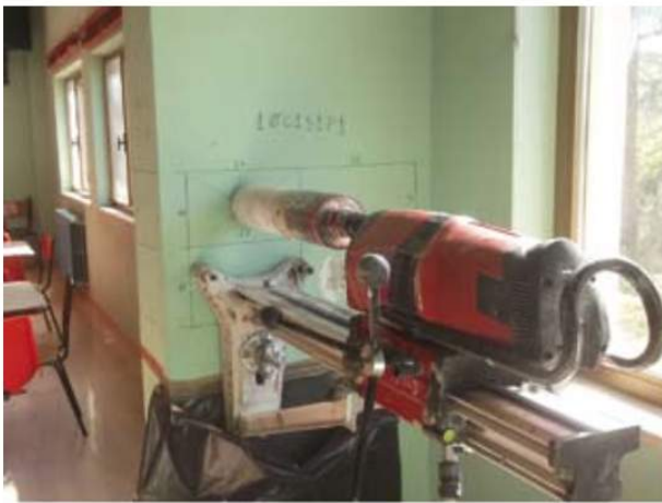
Prélèvement d'échantillons cylindriques
