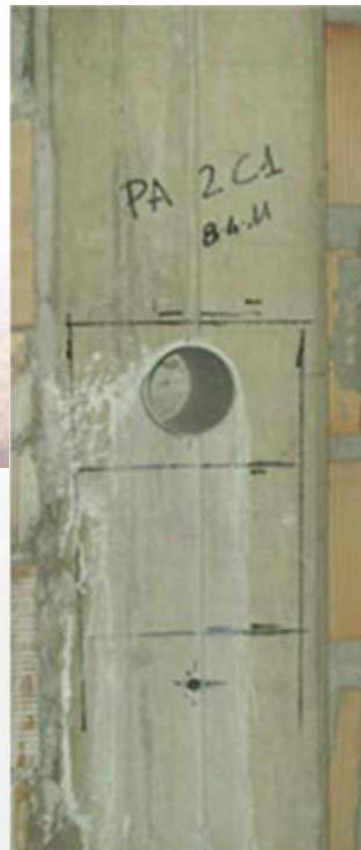
Analyses pachométriques pour l'extraction de l'échantillon de béton
