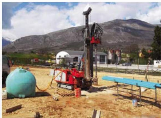
Construction de puits d'eau
