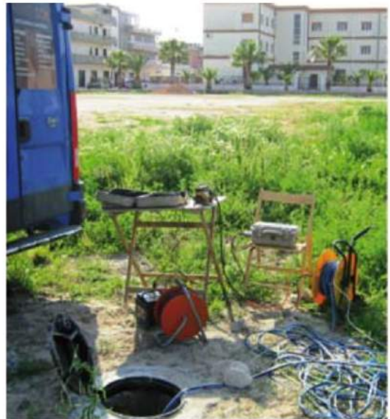
Sismique DOWN - HOLE
